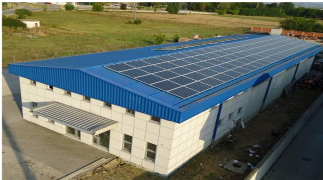
Slika 2. Solarna elektrana u Leskovcu
