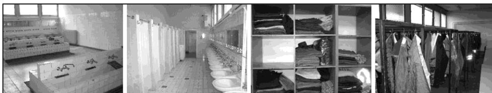
SLIKA 2: Sanitarni čvor– kanalizacija Leskovac
