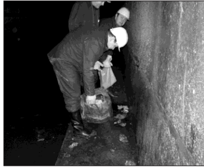
SLIKA 7: Deratizacija sabirnog kanala
